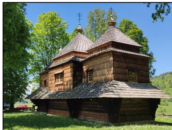
Obr. 5. Smolnik – dřevěný kostel.
