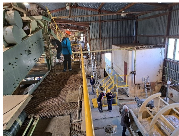
Obr. 2. Úpravna suroviny (foto T. Hodková).
